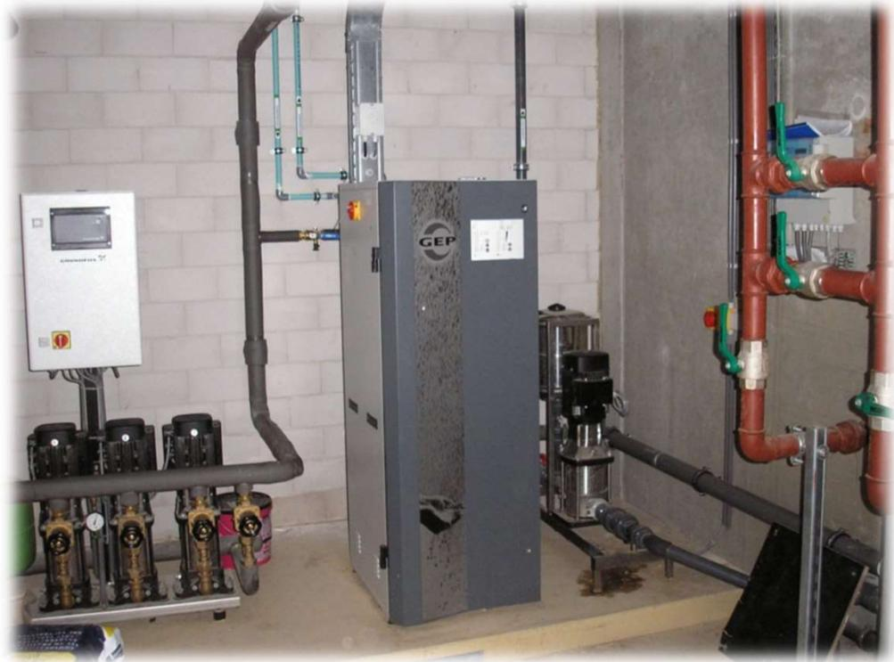
2 Beton Zisternen a 15.000 Liter laufen in einen Versickerungsbecken mit 30.000 Liter, IRM-Wassermanager. Das Regenwasser wird für die Toilettenspülung verwendet.
